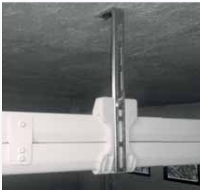
Staffe fissaggio a soffitto
